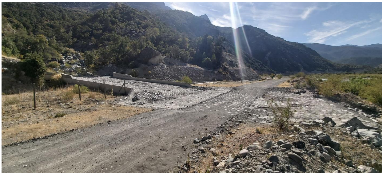
Figura 2-12. Estado actual cajón de arena cruce de quebradas
