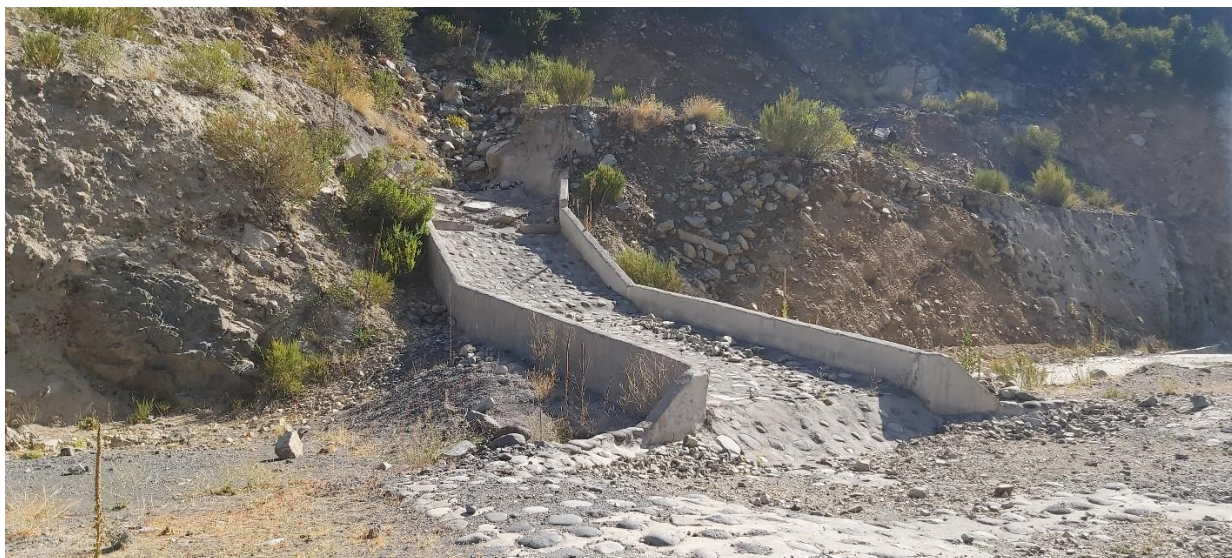
Figura 2-14 Estado actual cajón de arena cruce de quebradas
